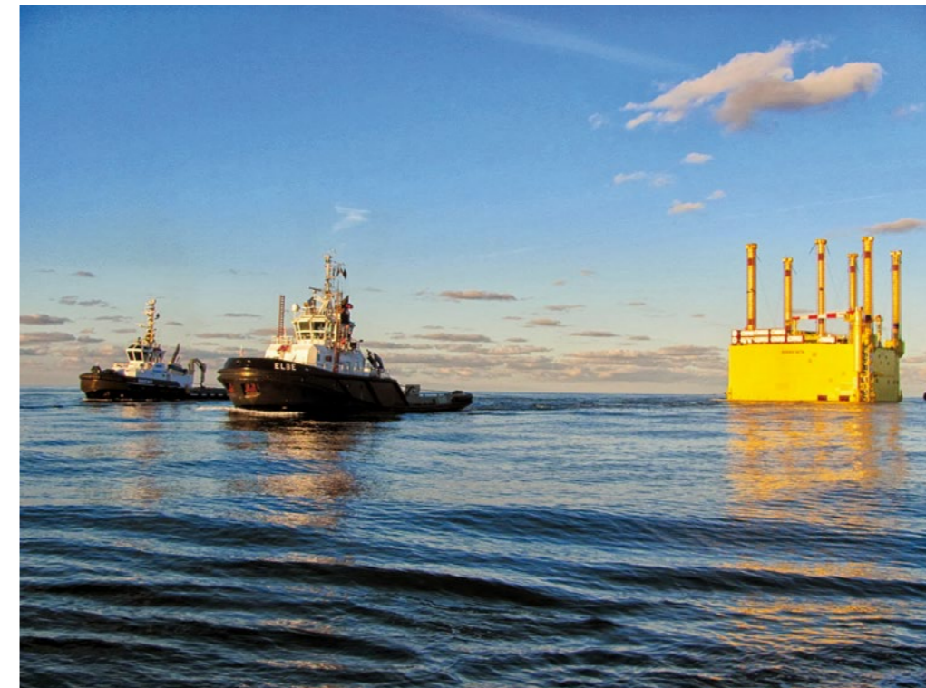
Verschleppung der 10.000 t schweren Konverterplattform Borwin Beta mit Seilen von Gleistein
